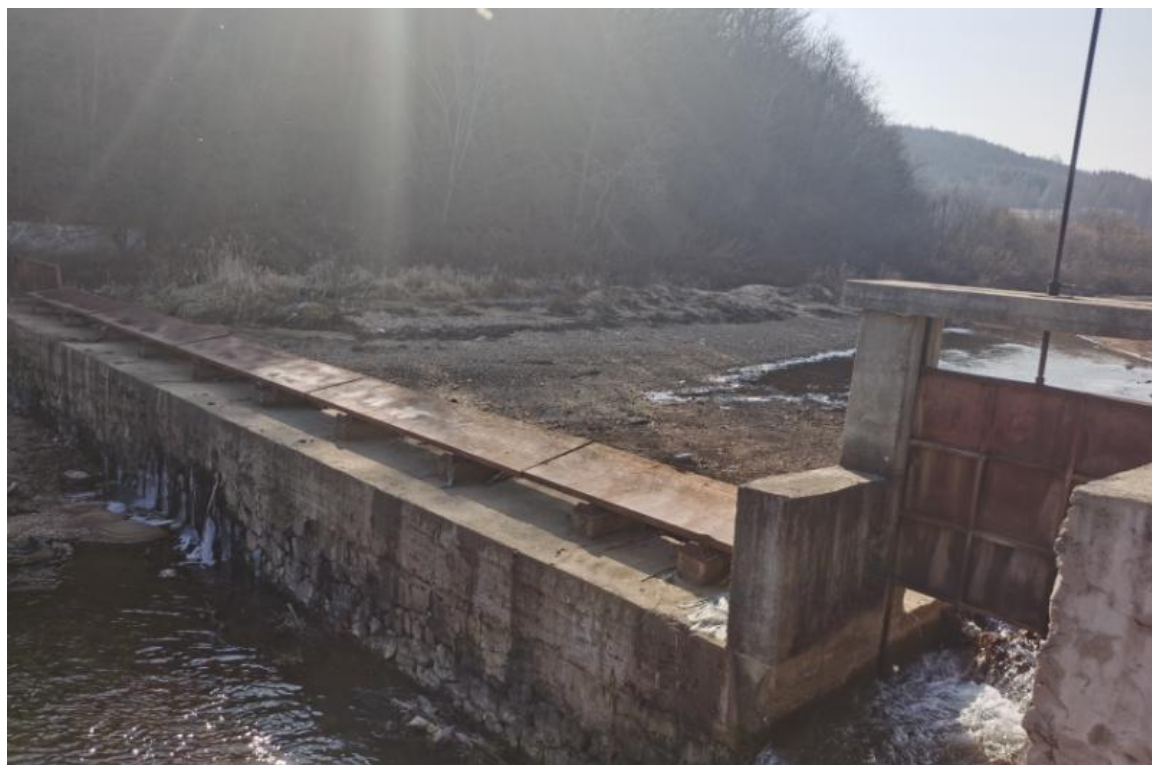
图 2.2-7 巨流河上翻板闸现状图
