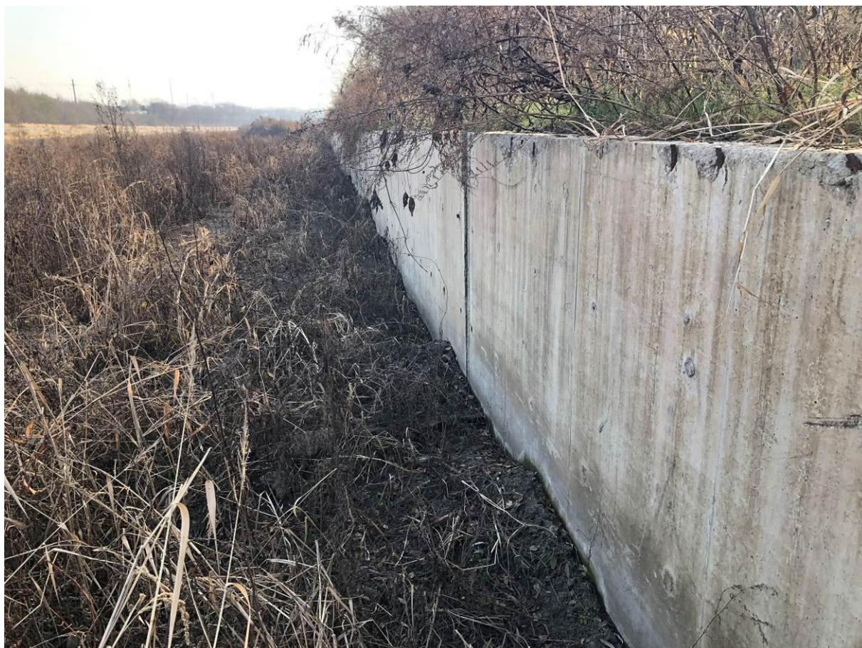
照片 2-2 古城子河干流混凝土挡墙现状
